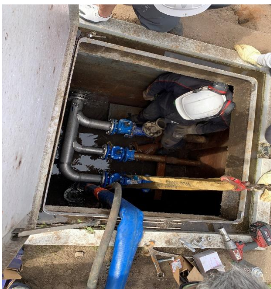
Vue de la chambre à vannes
